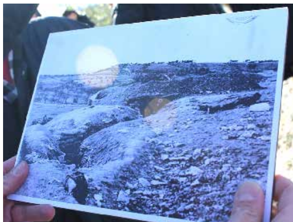
Photo d'époque des tranchées
